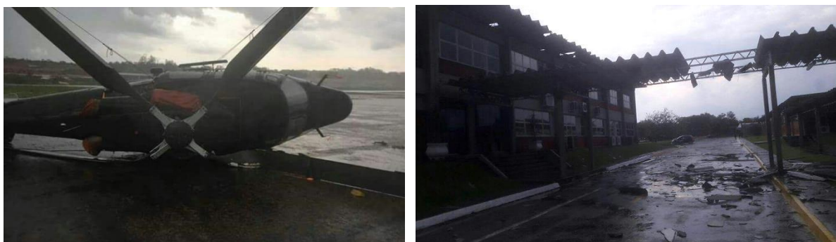
Figura 4.20 – Foto dos danos causados por fortes rajadas na Base Aérea SBTA – Taubaté, SP, em 27/10/2017 (fonte: O Vale).
